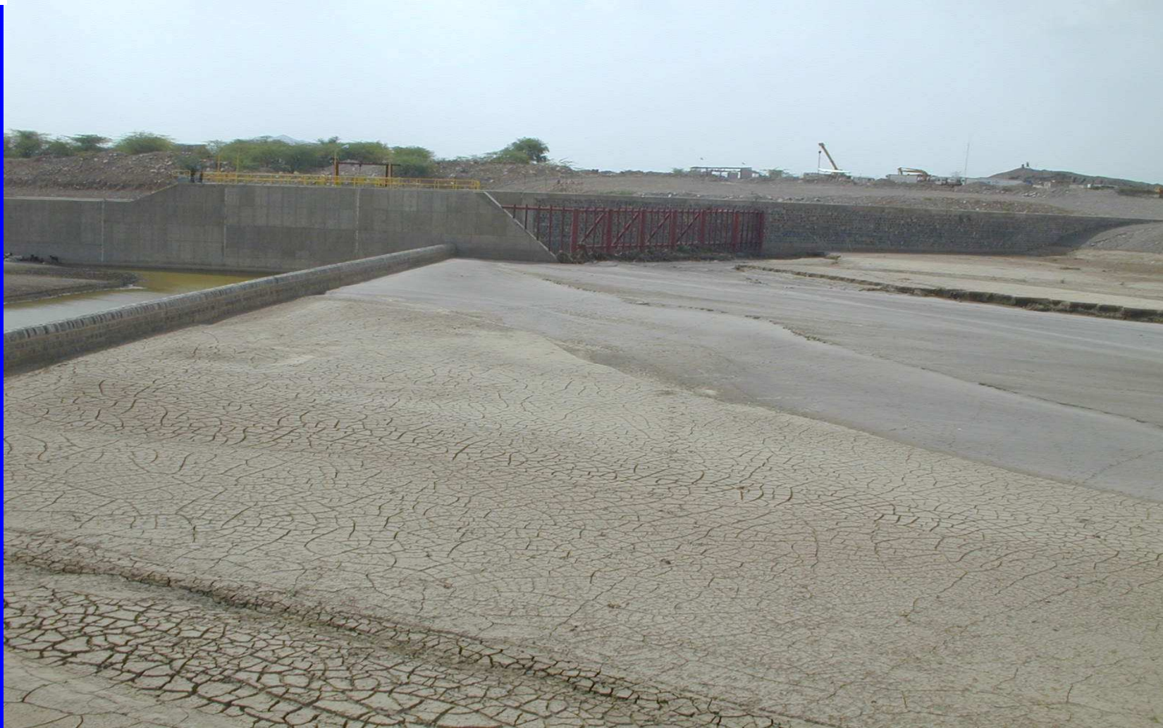
Diversion structure in Wadi Rima', Yemen 36
