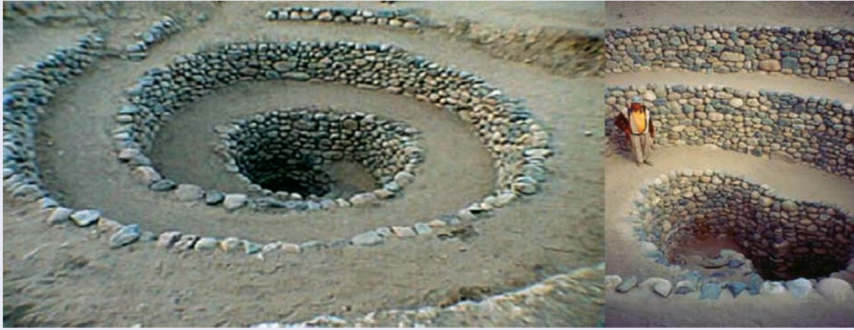
الشكل 5.11: نظام Nasca (الساحل الجنوبي لبيرو) لجمع المياه من أجل القنوات الجوفية لنقل المياه وتغذية طبقات المياه الجوفية الكائنة تحت النطاق المائي الساكن.
