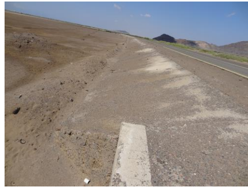
الشكل ٣٩ و ٤٠. الحماية للردميات المدكوكة بالخرسانة وهناك حاجز مؤقت صغير لخزن المياه في المنطقة العلوية للطريق ( الإمكانية هي استعمال بوابات في مداخل العبارات)
