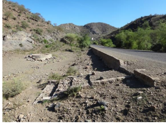
الشكل ١٣ و ١٤. موجّه مياه الفيضان (يسار) ومآخذ متدرج (يمين)
