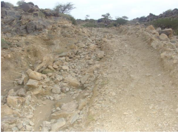
شكل ٤١ و ٤٢. خطر تطور الطرق الترابية لتصبح مجرى للفيضان – التصميم المناسب مع استخدام المنخفضات الممهدة وعمل مسارب لتصريف المياه الزائدة يكون مطلوباً
