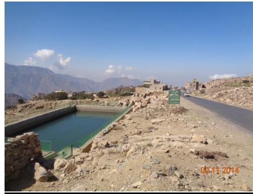
الشكل ٦ و ٧. تجميع المياه من مجرى الطريق والذي يتم على التوالي: من التصريف الجانبي (أعلى المنحدر) ومن مسرب التصريف الجانبي في أسفل المنحدر
