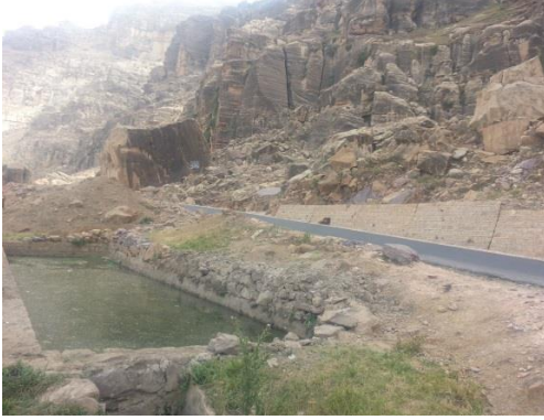
الشكل ٢٥. ٢٦. بركة تخزين مياه الينابيع في أسفل المنحدر وتنقل إليها المياه عن طريق أنبوب (الصورة على اليسار)، وحوض حماية لمياه العين أعلى المنحدر (الصورة على اليمين)
