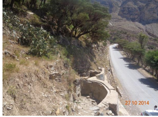
الشكل ٢٥. ٢٦. بركة تخزين مياه الينابيع في أسفل المنحدر وتنقل إليها المياه عن طريق أنبوب (الصورة على اليسار)، وحوض حماية لمياه العين أعلى المنحدر (الصورة على اليمين)
