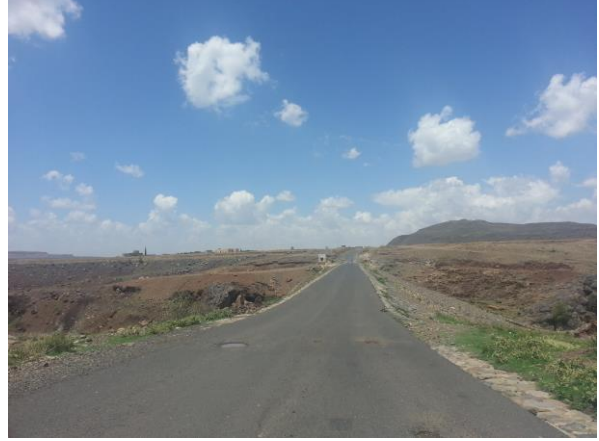
الشكل ٤٣ و ٤٤. استخدام جسم الطريق كسد تغذية للمياه الجوفية في الطريق الإسفلتية
