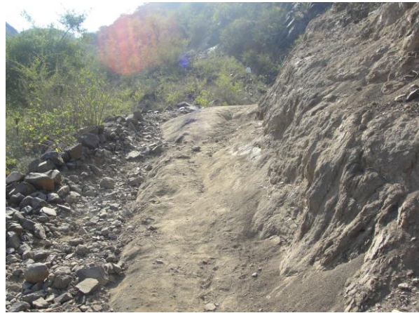
شكل ٤١ و ٤٢. خطر تطور الطرق الترابية لتصبح مجرى للفيضان – التصميم المناسب مع استخدام المنخفضات الممهدة وعمل مسارب لتصريف المياه الزائدة يكون مطلوباً
