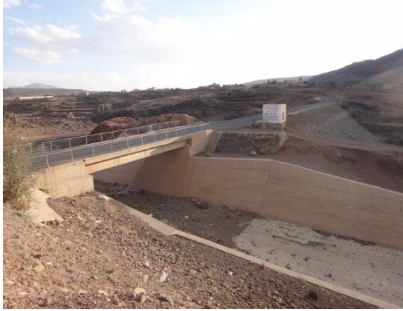
الشكل ٤٣ و ٤٤. استخدام جسم الطريق كسد تغذية للمياه الجوفية في الطريق الإسفلتية
