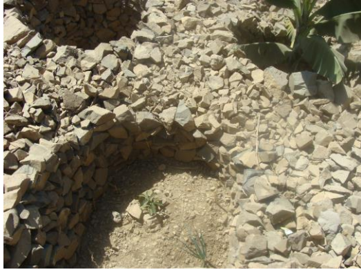
الشكل ١٧ و ١٨. التغطية بالأحجار – من أحجار المحاجر المحلية
