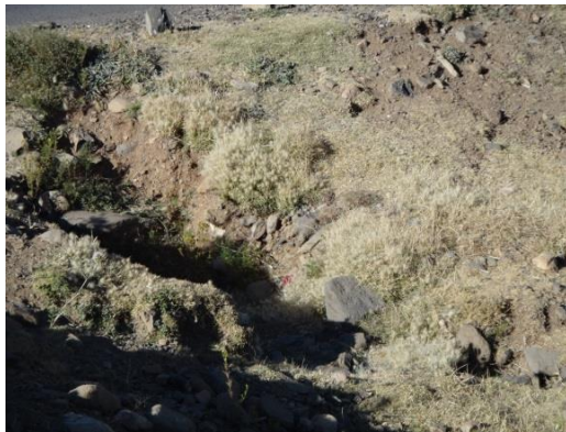
الشكل ١٠ و ٣١. تآكل وإنجراف من جريان من الطريق غير المتحكم به (الصورة على اليسار)، و جريان من طريق متحكم به (الصورة على اليمين)
