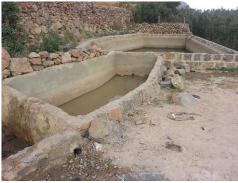
الشكل ٤ و ٥. برك تجميع المياه من المصارف الجانبية للطريق
