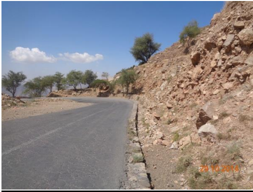
الشكل ٦ و ٧. تجميع المياه من مجرى الطريق والذي يتم على التوالي: من التصريف الجانبي (أعلى المنحدر) ومن مسرب التصريف الجانبي في أسفل المنحدر
