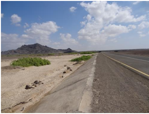
الشكل ٣٩ و ٤٠. الحماية للردميات المدكوكة بالخرسانة وهناك حاجز مؤقت صغير لخزن المياه في المنطقة العلوية للطريق ( الإمكانية هي استعمال بوابات في مداخل العبارات)
