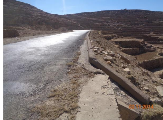
الشكل ١٠ و ٣١. تآكل وإنجراف من جريان من الطريق غير المتحكم به (الصورة على اليسار)، و جريان من طريق متحكم به (الصورة على اليمين)
