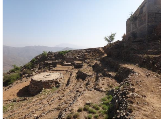
الشكل ٨ و ٩. سقاية (صهريج) تُملأ من المياه المحصودة من الطرق، والغطاء الحجري يستخدم لتحويل أول تدفق، منطقة الواسطة
