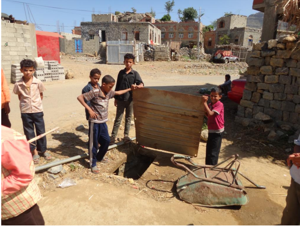
الشكل ١. سقاية (خزان مياه أرضي) تملأ من السيول المتدفقة من سطح الطريق
