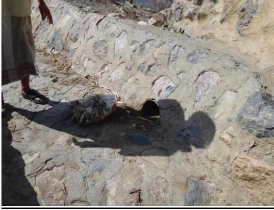
الشكل ٨ و ٩. سقاية (صهريج) تُملأ من المياه المحصودة من الطرق، والغطاء الحجري يستخدم لتحويل أول تدفق، منطقة الواسطة
