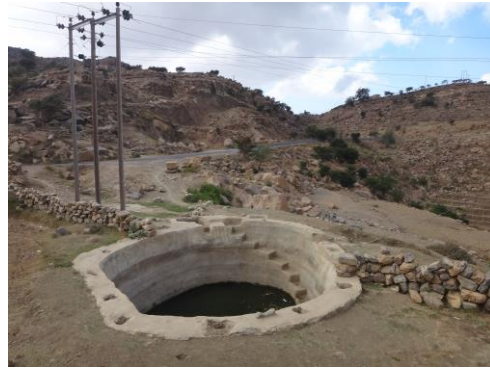
الشكل ٤ و ٥. برك تجميع المياه من المصارف الجانبية للطريق
