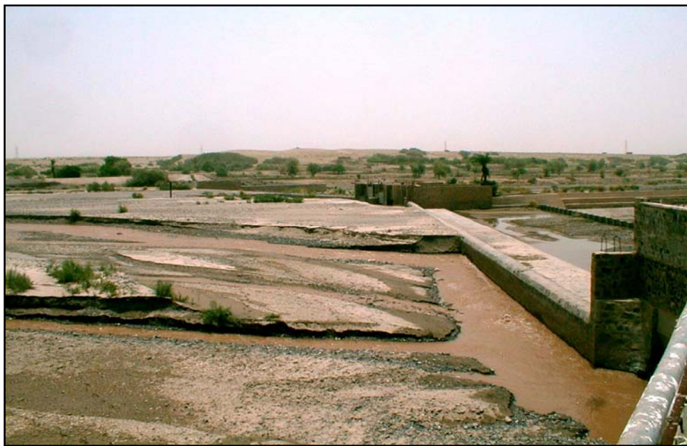
Ras Al Wadi weir showing arrangement for division of Wadi Tuban flow into Wadi Kabir and Wadi Saghir.
