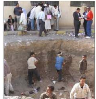
صورة (٥,٣) : تسوية الحفر باستخدام العمال
