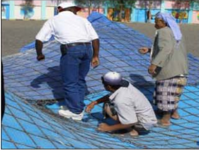
صوره (٥, ٤٠): خياطة الطربال (القماش المشمع) من اسفل حديد التسليح
