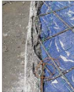
صوره (٥, ٤٢): ثني وترتيب قضبان حديد التسليح البارزة من جدار وسقف الخزان مع بعضها
