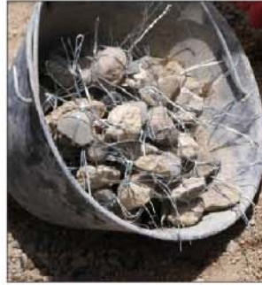
صورة (١١, ٥): سلك ربط الحديد مربوط حول الاحجار لتثبيت حديد التسليح
