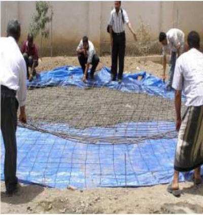
صورة (٤,١٠): ربط حديد الحائط الرأسي بحديد القاعدة الافقي مع بعضهما بسلك التريبط
