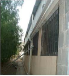
صوره (٥,٥٢): أنابيب تجميع وتوصيل المياه من السقف الى الخزان
