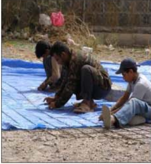
صورة (٤, ٣٦): خياطة الطربال على حديد تسليح السقف
