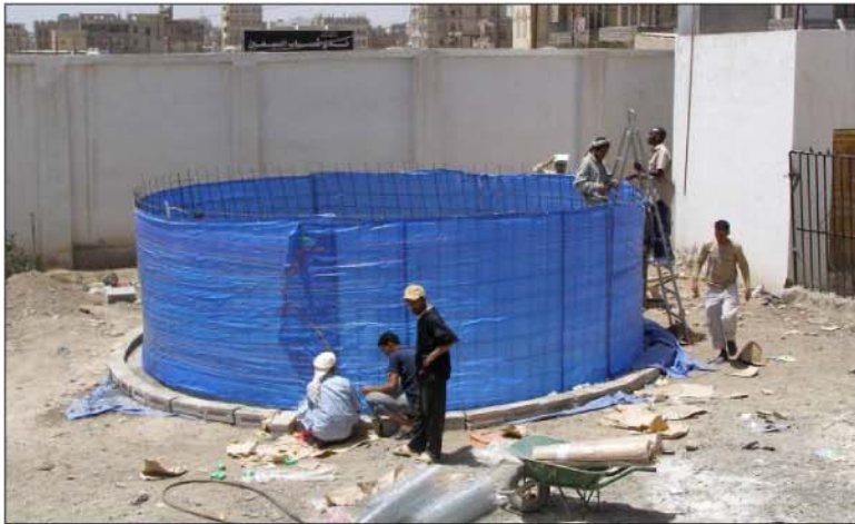
صورة (٤,١٢): لف الطربال البلاستيكي باحكام حول حديد التسليح وثبينة بالحبال
