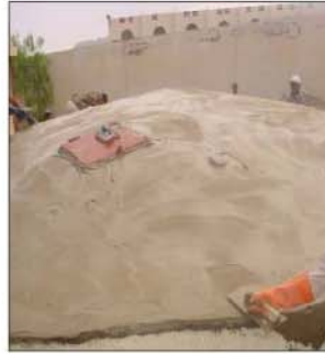
صوره (٥,٤٧) : تلبيس المونة الاسمنتية على السقف
