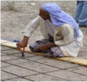
صورة (٥, ٤): كل تقاطعات قضبان التسليح تربط مع بعضها بسلك التريبط
