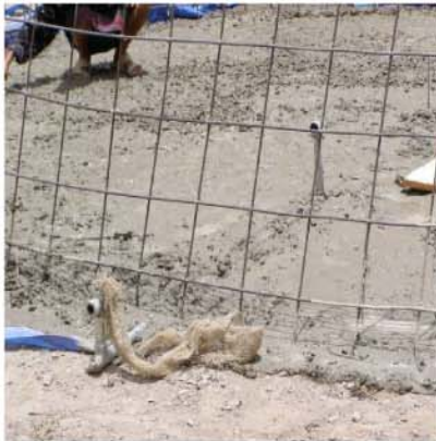
صورة (٤,١١): تثبيت انبوب تصريف المياه من الخزان الى حديد تسليح القاعدة قطريا من المركز
