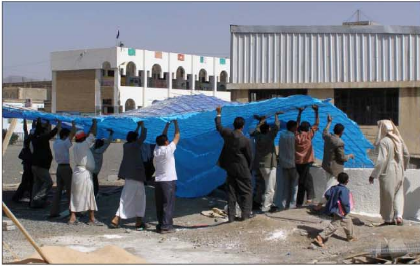
صوره (٥, ٤١): تركيب حديد سقف الخزان
