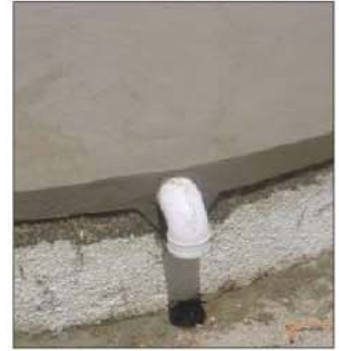
(٥,٤٦) : تلبيس المونة الاسمنتية على السقف
