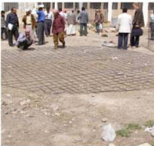
صورة (٧, ٤): حديد تسليح الاساس، وضع قضبان حديد للاساس بزاوية قائمة
