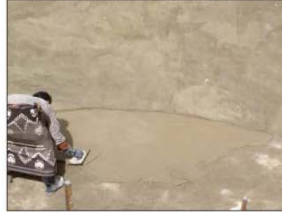
صوره (٥, ٣٦): عمل طبقة التلبيس الاخيرة لارضية الخزان
