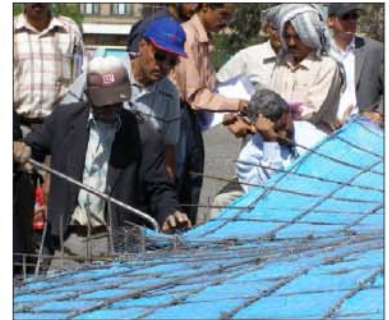
صوره (٥, ٤٢): ثني وترتيب قضبان حديد التسليح البارزة من جدار وسقف الخزان مع بعضها
