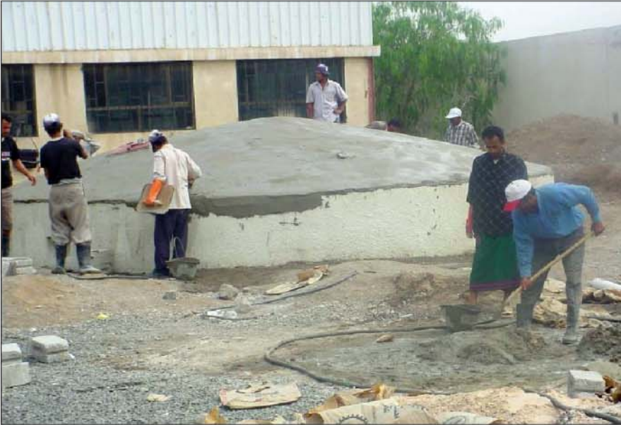
صورة (٥٥، ٥): تلبيس السقف بالمونة الاسمنتية
