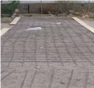
صورة (٦, ٤): تجهيز قضبان حديد التسليح لتشكيل شبكة للجدار
