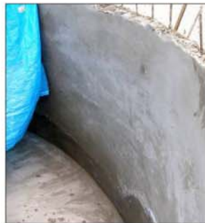
صورة (٤, ٢٨): تغطية حائط وارضية الخزان بطبقة عازلة
