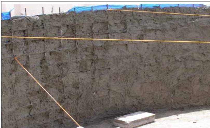
صورة ( ١٦ , ٤ ) بعض الحبال المربوطة قطريا من الداخل للحصول على شكل اسطواني صحيح
