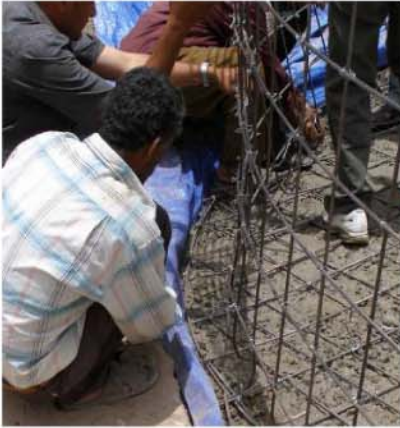
صورة (٤,٩): وضع حديد تسليح الاساس على الطبقة الأولى من خرسانة الأساس.
