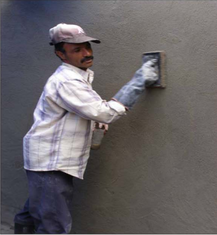
صورة (٤, ٢٦): تنعيم السطح الداخلي لجدار الخزان باليد الخشبية
