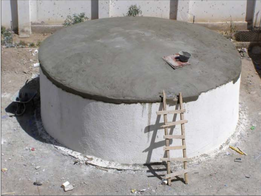
صورة (٤٢, ٤) : السقف بعد عمل التلييس
