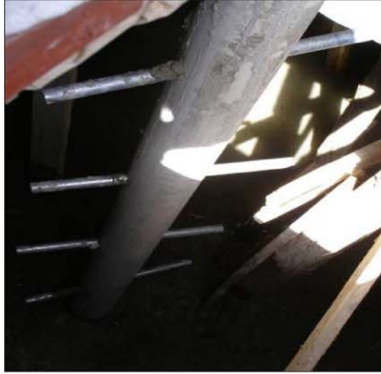
صورة (٤٣، ٤): العمود جوار الفتحة مع الانابيب الافقية التي تستخدم كسلم
