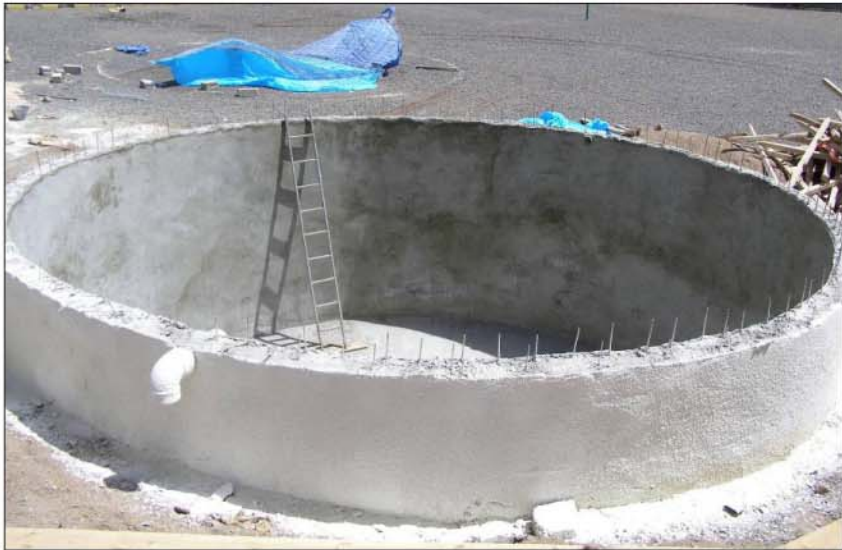
صوره (٥,٣٨): الخزان جاهز لتركيب السقف
