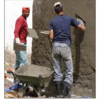
صورة (٤, ٣٣): عمل طبقة التلبس النهائية من الخارج
