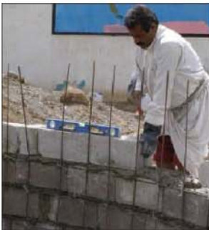
صوره (٥, ١٩): بناء صفوف البلك
