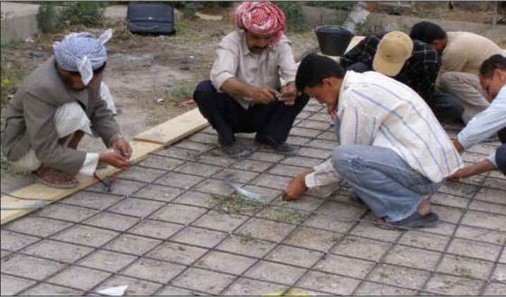
صورة ٤, ٤ تجهيز حديد التسليح للجدار بشكل شبكة وتربيطه بالسلك
