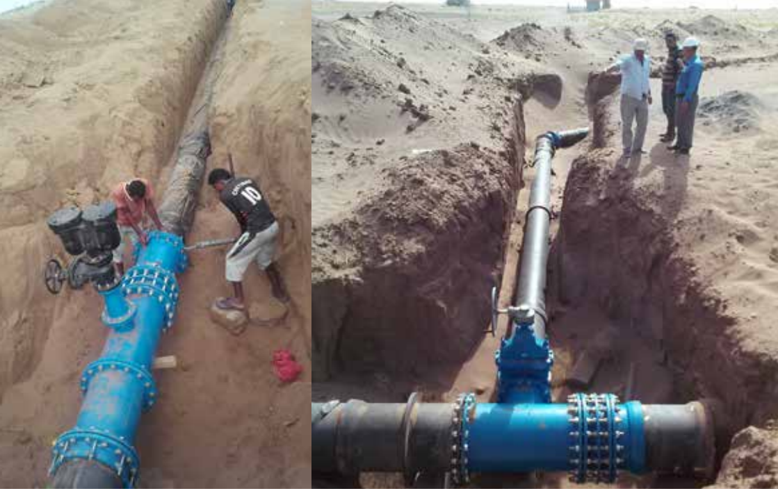
الشكل ١٦ تنفيذ العدادات والمحابس لتقسيم شبكة مياه الحديدية الى عدة مناطق
