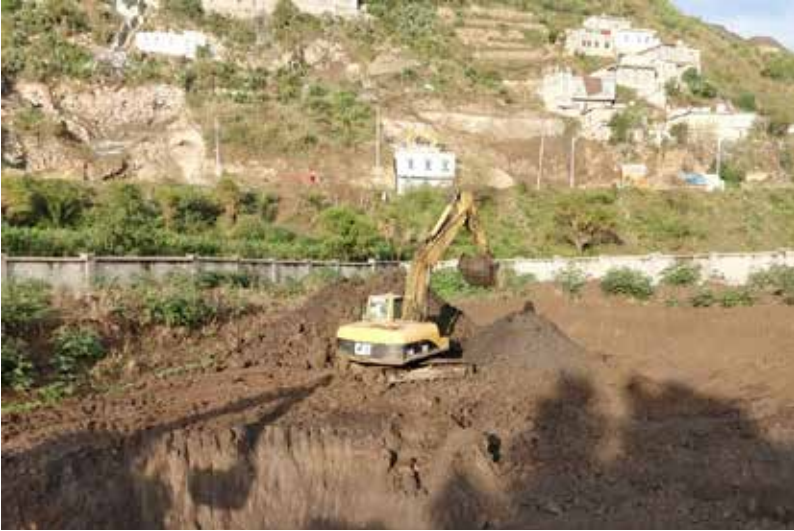
الشكل ٢٩ أحواض التغذية أثناء التنفيذ والتشغيل
