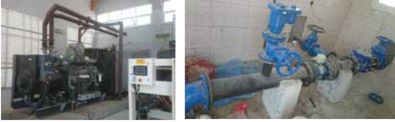
الشكل ١٧ وحدات إدارة الضخ والضغط في شبكة الحديدية
