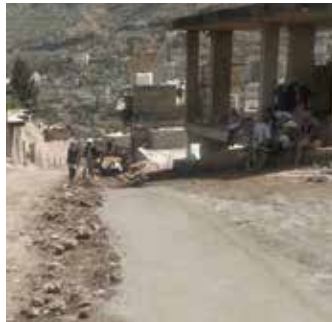
الشكل ٤ خط الأنابيب المنفذ من قبل الجمعية التعاونية في مرفق المياه والصرف الصحي- إب
